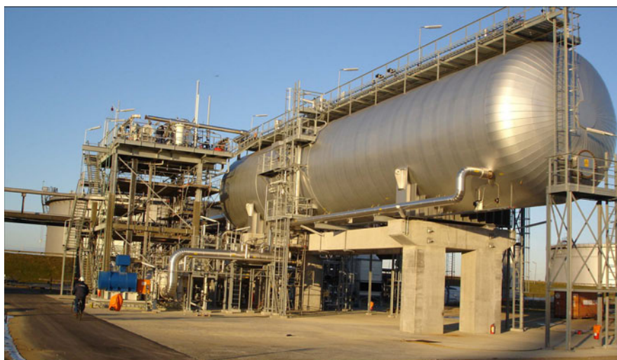
Eksisterende afgasningsanlæg på DONG olierørs råolieterminal
