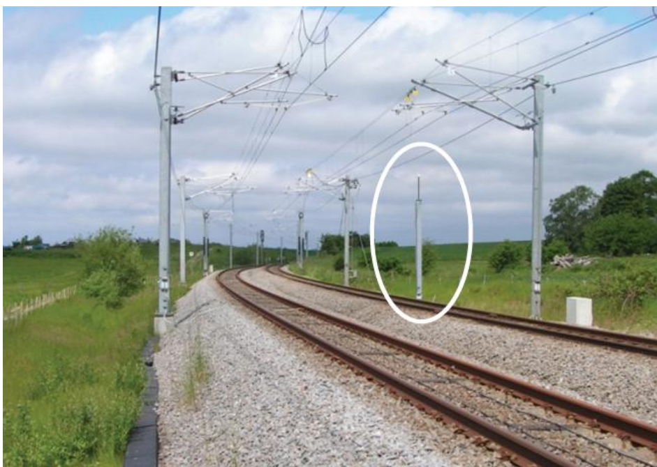
Fremtidige forhold med antennemast og antenne i forbindelse med det nye signalsystem. Der opstilles master for hver ca. 600 meter.
